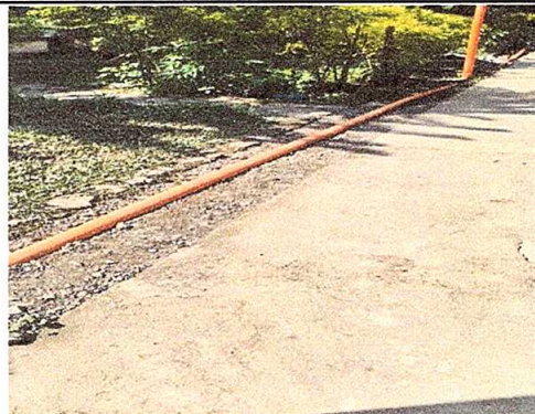
Foto 4: Sustrucción de canal de metal
