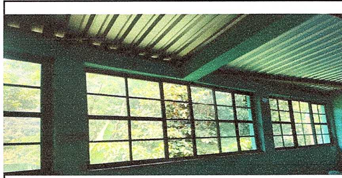
Foto 6: Pintura de muros exteriores
