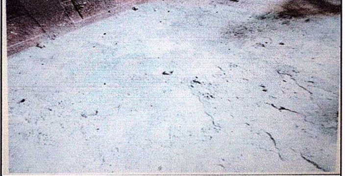
Foto 2: Sustrucción de piso de granito
