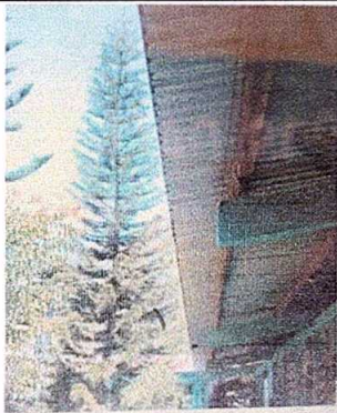
Foto 3: Sustrucción de canal de metal
