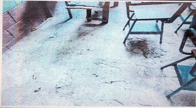
Foto1: Sustrucción de piso de granito
