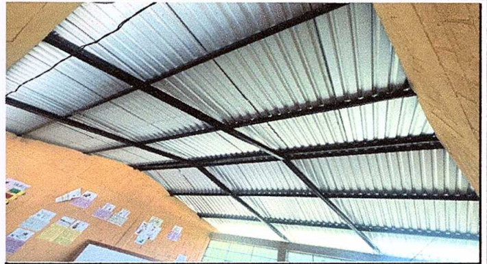
Foto 2: Sustrucción de estructura de soporte de madera por metal, elementos de fijación y capotes de lámina para lámina troquelada en tres aulas.
