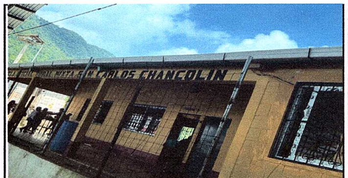
Foto 6: Sustrucción de Canal de PVC de 5 aulas.
