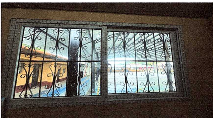
Foto 3: Sustrucción de ocho ventanas de 1.26 metros de alto por 2.1 metros de ancho en 2 aulas.
