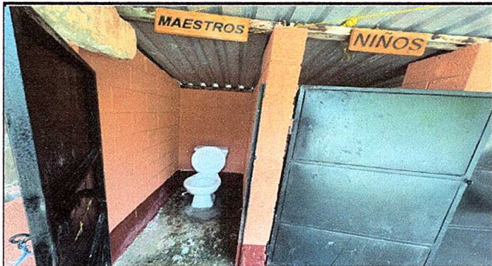
Foto 7: Sustrucción de cuatro inodoros.
