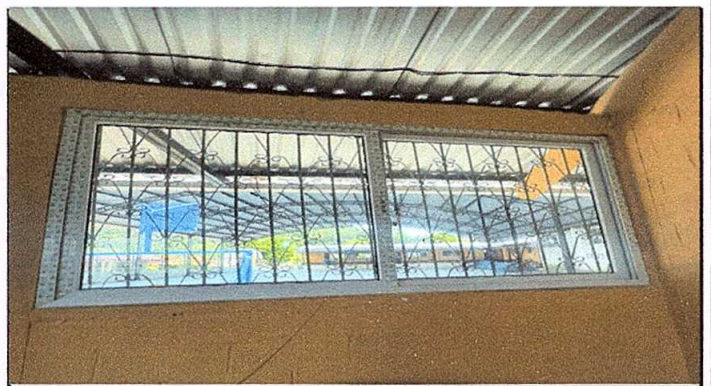
Foto 4: Sustrucción de seis ventanas de 1.50 metros de alto por 2.55 metros de ancho en 3 aulas.
