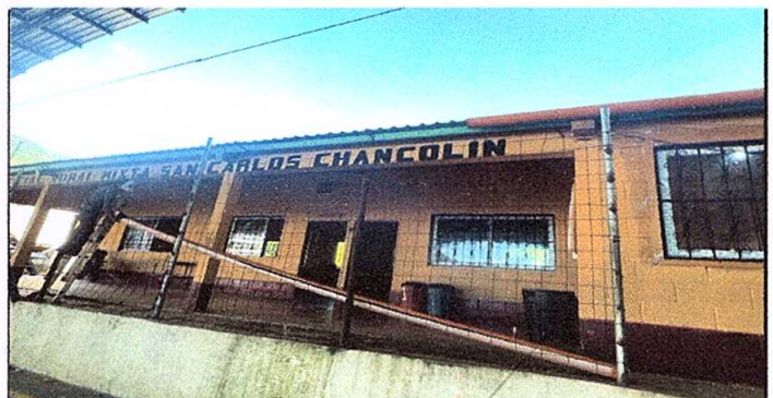
Foto 6: Sustitución de Canal de PVC de 5 aulas.
