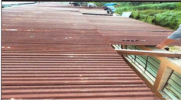
Foto 1: Sustitución de lámina por lámina troquelada aluzinc calibre 26, en 3 aulas.
