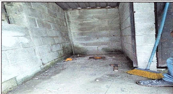
Foto 7: Sustitución de cuatro inodoros.
