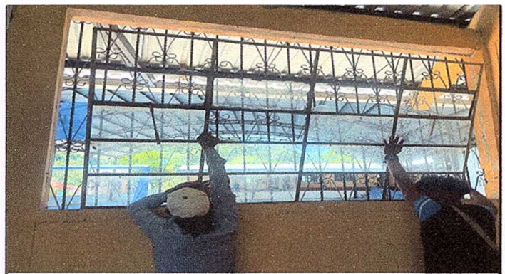
Foto 4: Sustitución de seis ventanas de 1.50 metros de alto por 2.55 metros de ancho en 3 aulas.
