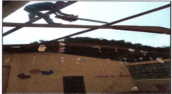
Foto 2: Sustitución de estructura de soporte de madera por metal, elementos de fijación y capotes de lámina para lámina troquelada en tres aulas.
