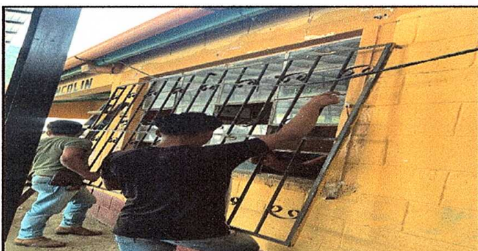
Foto 5: Sustitución de seis balcones de 1.26 metros de alto por 2.1 metros de ancho para 2 aulas.
