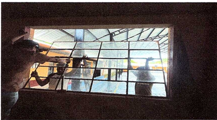
Foto 3: Sustitución de ocho ventanas de 1.26 metros de alto por 2.1 metros de ancho en 2 aulas.
