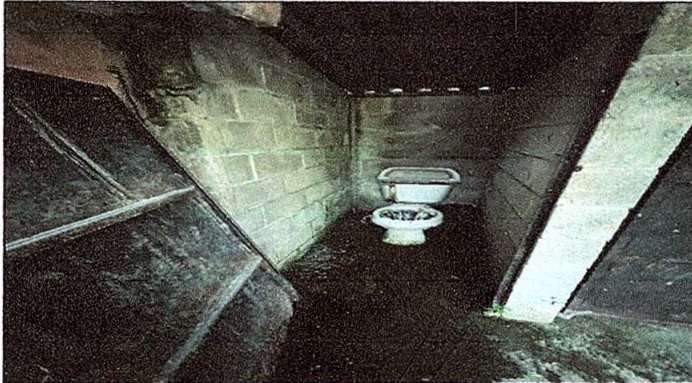
Foto7: Sustrucción de cuatro inodoros.
