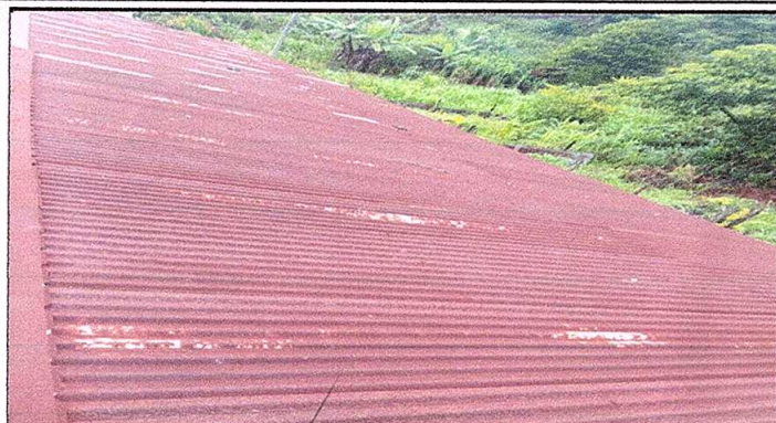
Foto 1: Sustrucción de lámina por lámina troquelada aluzinc calibre 26, en 3 aulas.
