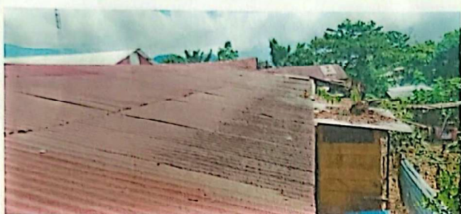
Foto 1: Cubierta de lámina
