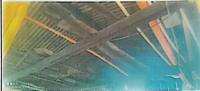
Foto 2: Estructura de techo
