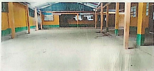
Foto 5: Pintura en muros exteriores e interiores
