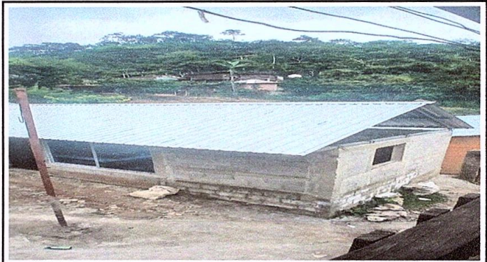
Foto 2: Sustrucción de laminas, por laminas troqueladas
