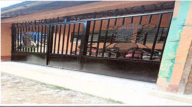
Foto 7: Sustitución de portón de madera, por metal
