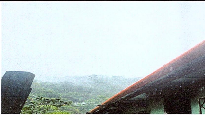
Foto 9: Mejoramiento de canaletas.
