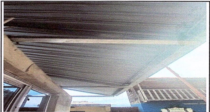
Foto 4: Sustrucción de Estructura de madera por metal.
