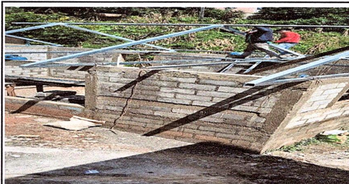
Foto 4: Sustrucción de Estructura de madera por metal.
