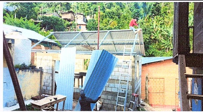
Foto 2: Sustrucción de laminas, por laminas troqueladas
