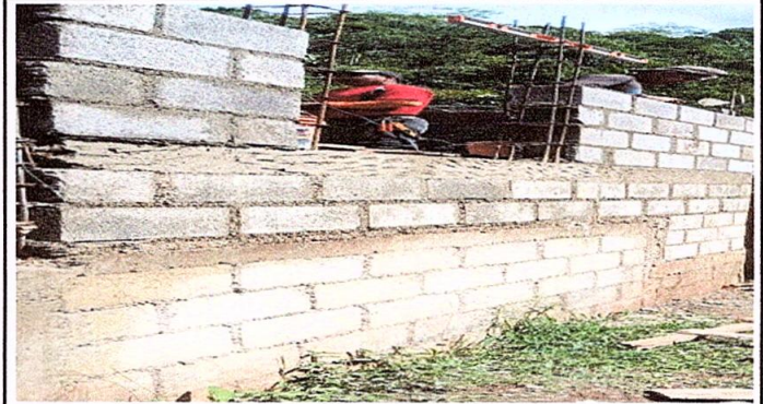
Foto 8: Mejoramiento de pared
