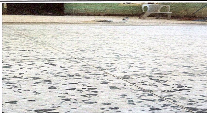
Foto 1: Sustrucción de piso de torta de concreto, por piso de granito
