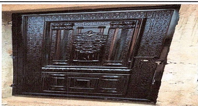
Foto 5: Sustrucción de puerta de madera, por metal
