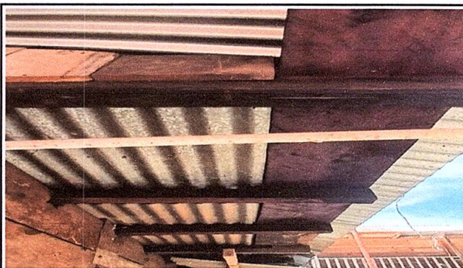
Foto 4: Sustrucción de Estructura de madera por metal.
