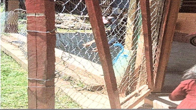
Foto 7: Sustrucción de p6rt6n de madera, por metal
