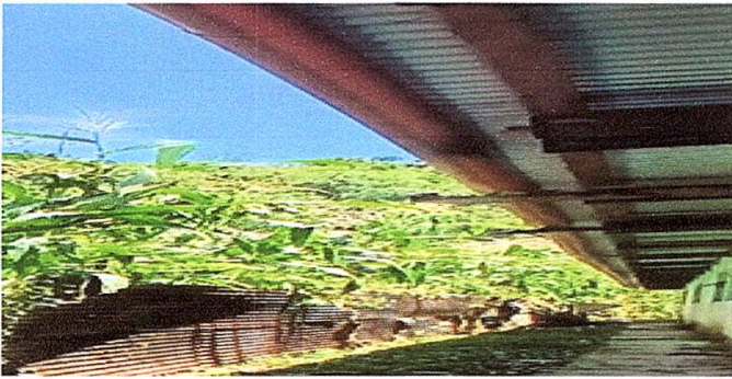
Foto 9: Mejoramiento de canaletas.
