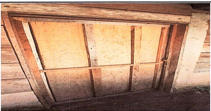
Foto 5: Sustrucción de puerta de madera, por metal
