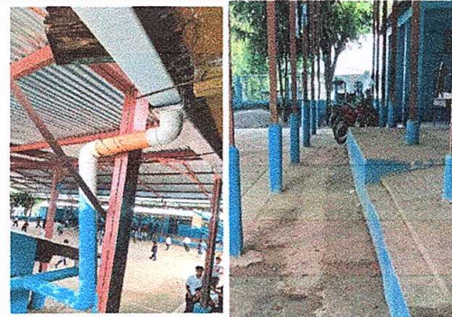
Foto 6: Tubería PVC conectada a linea principal de aguas pluviales
