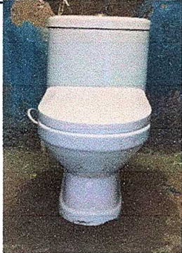
Foto 3: Sustitucion de sanitarios
