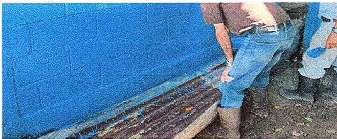
Foto 5: Pintura detereorada
