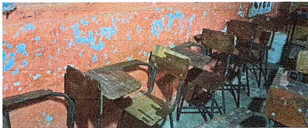
Foto 5: pintura detereorada
