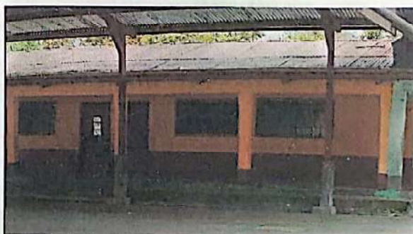
Foto 6: Techo de aulas
