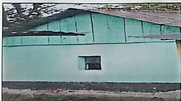
Foto 5: Techo de cocina
