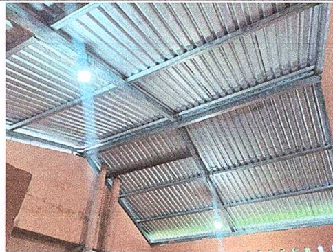
Foto 2: Sustitución de estructura de soporte de metal, por metal
