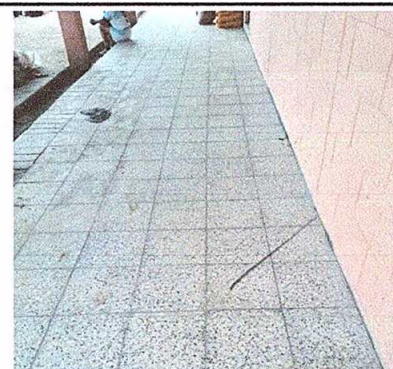
Foto 4: Sustitución de piso de torta de concreto por piso de granito.
