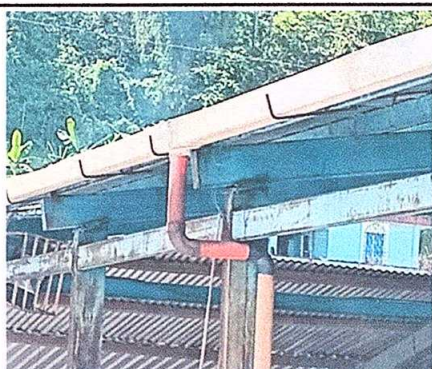
Foto 3: Sustitución de canal de pvc, sustitución de bajada de agua pluvial, tubo PVC 3"
