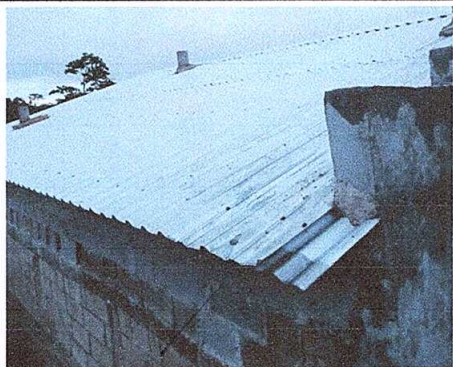
Foto 1: Sustitución de lámina, por lámina troquelada aluzinc calibre 26, sustitución de capote de lámina para lámina troquelada, sustitución de elementos de fijación
