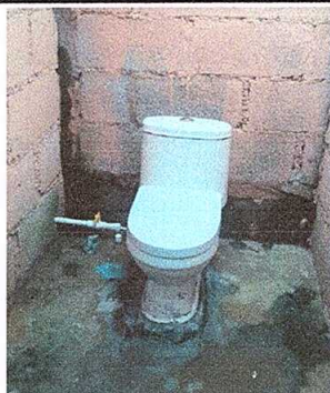
Foto 5: Sustitución de inodoro
