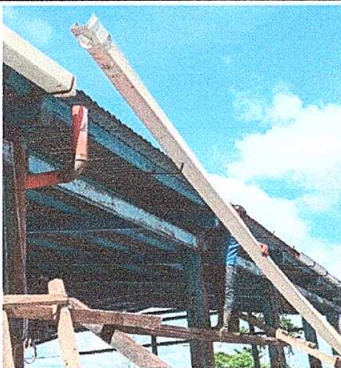
Foto 3: Sustitución de canal de pvc, sustitución de bajada de agua pluvial, tubo PVC 3"
