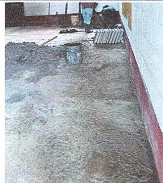
Foto 4: Sustitución de piso de torta de concreto por piso de granito.
