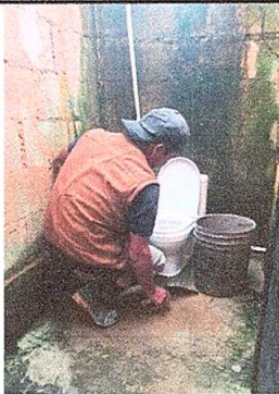
Foto 5: Sustitución de inodoro
