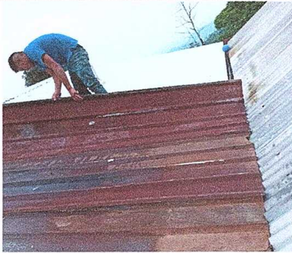
Foto 1: Sustitución de lámina, por lámina troquelada aluzinc calibre 26, sustitución de capote de lámina para lámina troquelada, sustitución de elementos de fijación
