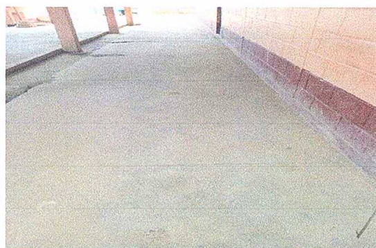
Foto 4: sustitucion de piso de torta de concreto por piso de granito
