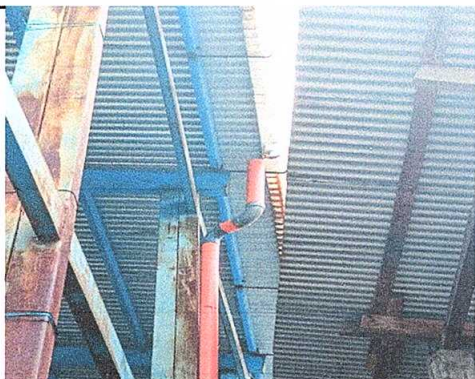
Foto 3: Susutitucion de canal de pvc, Susutitucion de bajada de agua pluvial, tubo pvc 3"
