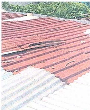
Foto 1: Sustitución de lámina, por lámina troquelada aluzinc calibre 26, Sustitución de capote de lámina para lámina troquelada, Sustitución de elementos de fijación.
