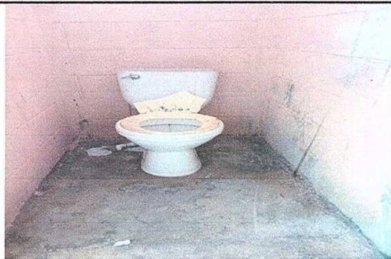
Foto 5: Sustitucion de inodoro
