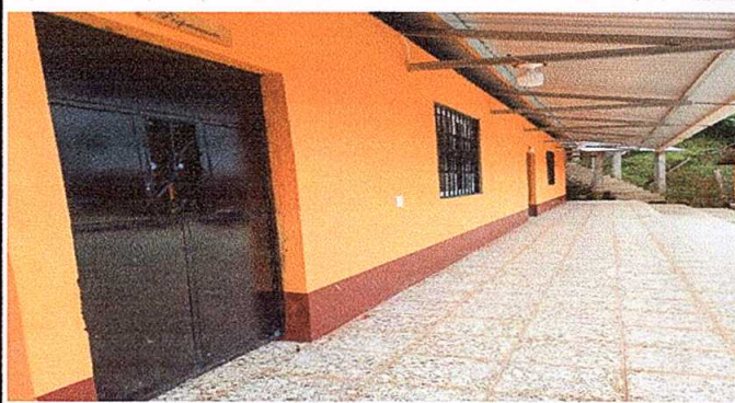
Foto 3: SUSTITUCIÓN DE PUERTAS (0.98x2.10 metros)
