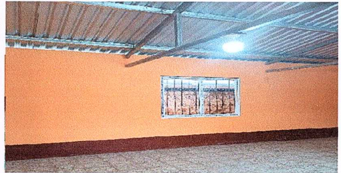
Foto 8: REPARACIÓN DE REPELLO Y CERNIDO DE PAREDES
