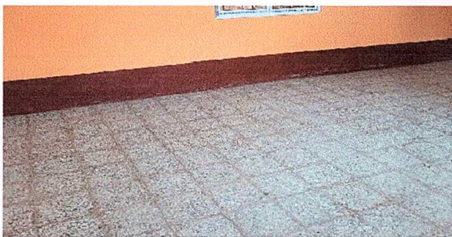
Foto 9: SUSTITUCIÓN DE PISO DE GRANITO
