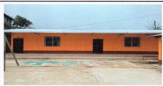
Foto 6: PINTURA EN MUROS EXTERIORES E INTERIORES
