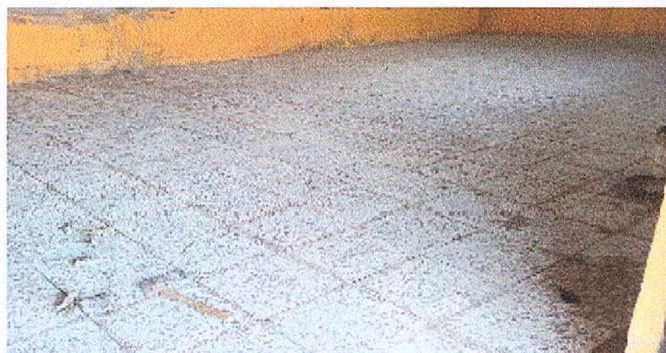
Foto 9: SUSTITUCIÓN DE PISO DE GRANITO
