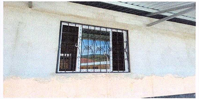
Foto 4: SUSTITUCIÓN DE VENTANAS DE MADERA POR METAL MÁS VIDRIO
