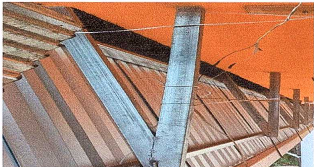
Foto 7: REPARACIÓN DE SISTEMA ELÉCTRICO
