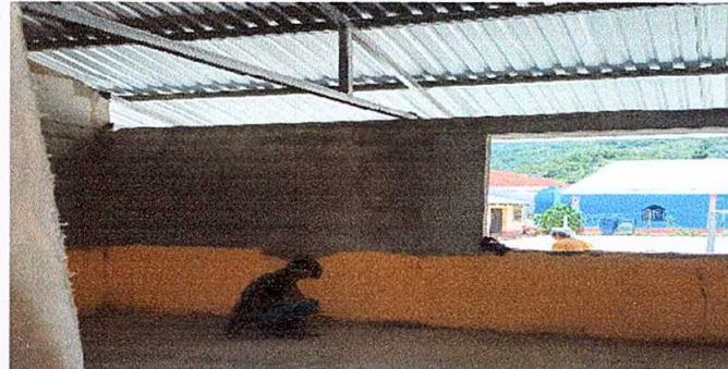
Foto 8: REPARACIÓN DE REPELLO Y CERNIDO DE PAREDES
