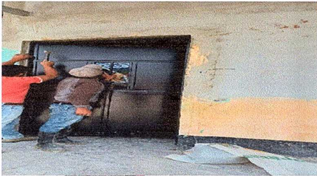
Foto 3: SUSTITUCIÓN DE PUERTAS (0.98x2.10 metros)
