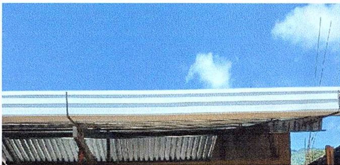
Foto 5: SUSTITUCIÓN DE CANAL DE PVC
