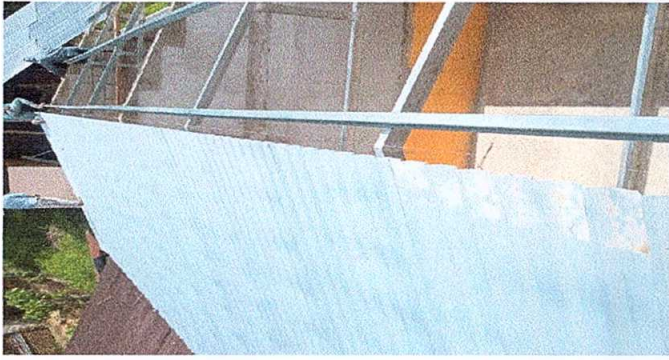
Foto1: SUSTITUCIÓN DE LÁMINA, POR LÁMINA TROQUELADA ALUZING CALIBRE 26
