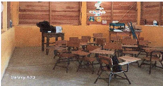
Foto 9: SUSTITUCIÓN DE PISO DE GRANITO
