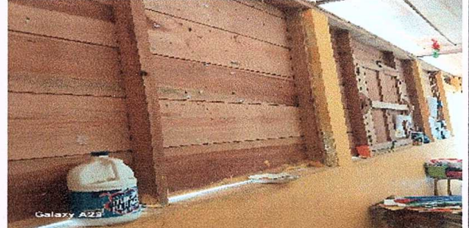
Foto 8: REPARACIÓN DE REPELLO Y CERNIDO DE PAREDES
