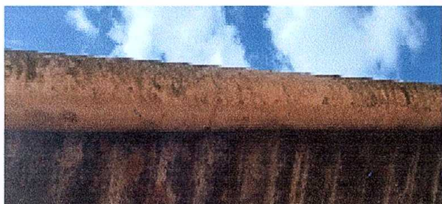
Foto 5: SUSTITUCIÓN DE CANAL DE PVC
