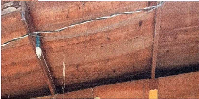
Foto 7: REPARACIÓN DE SISTEMA ELÉCTRICO
