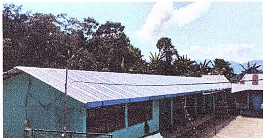
SUSTITUCIÓN POR LÁMINA TROQUELADA
