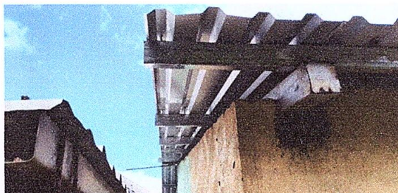
SUSTITUCIÓN POR ESTRUCTURA DE METAL
