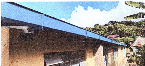
SUSTITUCIÓN POR CANALES DE METAL
