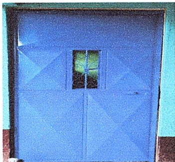
SUSTITUCIÓN POR PUERTA DE METAL
