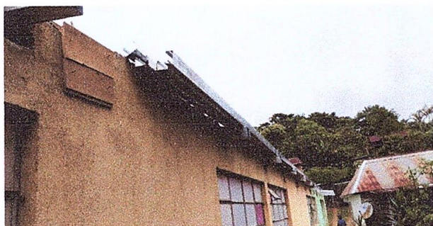
SUSTITUCIÓN POR CANALES DE METAL
