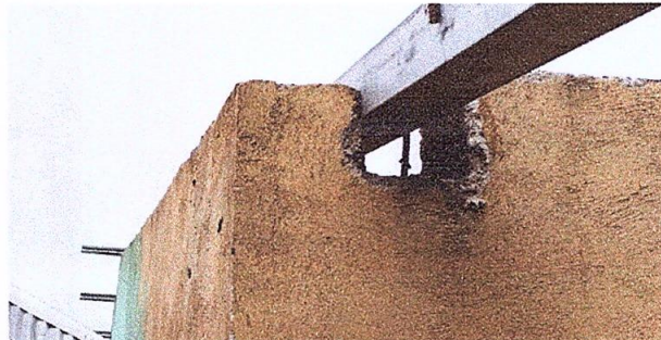
SUSTITUCIÓN POR ESTRUCTURA DE METAL
