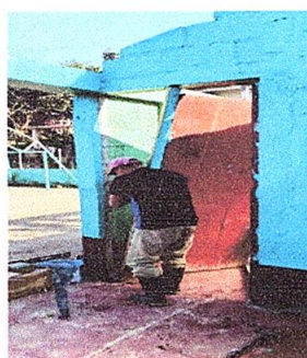
SUSTITUCION DE PUERTA DE METAL POR METAL
