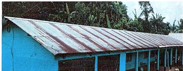
SUSTITUCIÓN POR LÁMINA TROQUELADA
