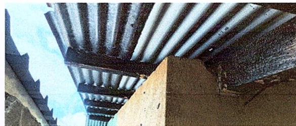
SUSTITUCIÓN POR ESTRUCTURA DE METAL
