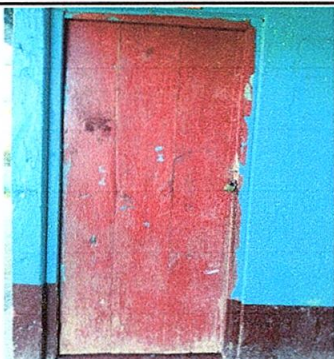
SUSTITUCIÓN POR PUERTA DE METAL
