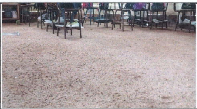
Foto 11: Sustitución de piso de torta de concreto por piso de granito.
