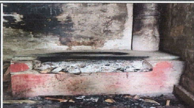
Foto 7: Mejoramiento estufa artesanal (Chimenea y Plancha de metal).
