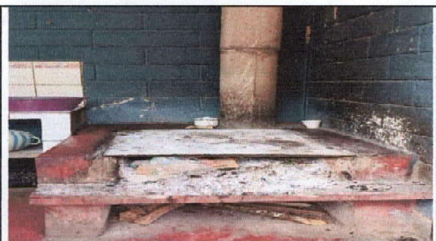
Foto 9: Mejoramiento estufa artesanal (Chimenea y Plancha de metal).
