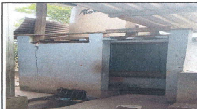
Foto 10: Sustitución de urinal completo (sistema de agua, drenaje).
