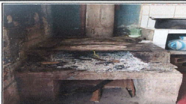
Foto 8: Mejoramiento estufa artesanal (Chimenea y Plancha de metal).
