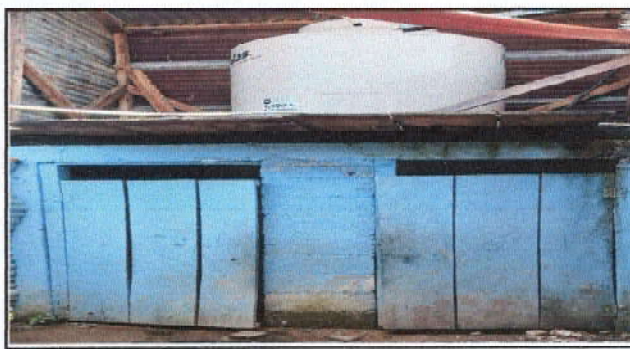
Foto 12: Sustitución de puerta en servicios sanitarios de 1.80 mts x 80 cms.
