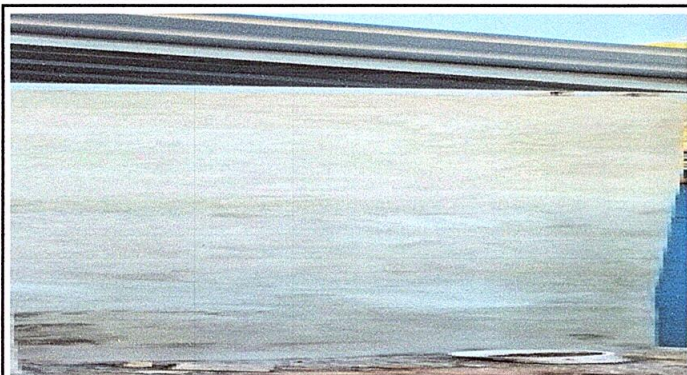
Foto 7: Repello en muro
