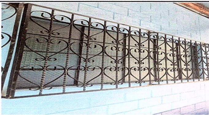
Foto 3: Sustitucion de balcones de metal
