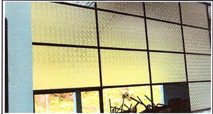
Foto 2: Sustitucion de ventanas de metal, más vidrios
