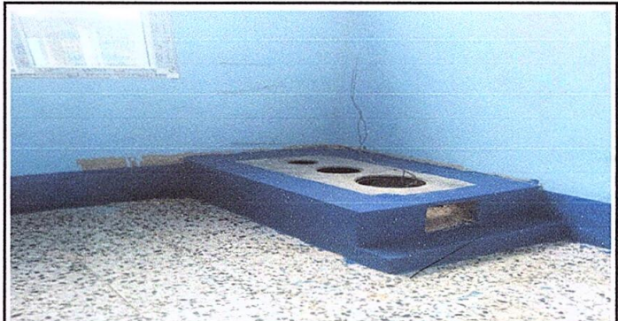
Foto 6: Sustitución de plancha de metal de 3 hornillas
