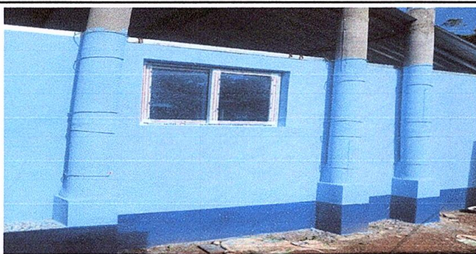
Foto 5: Sustitución de chimenea de metal por concreto.
