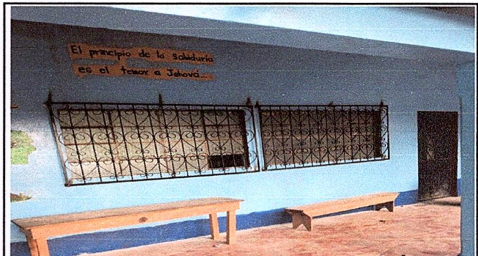
Foto 4: Pinturas en muros exteriores e interiores
