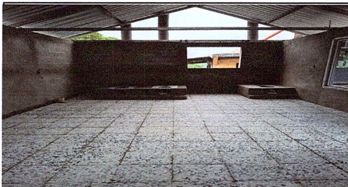
Foto1: Sustitución de piso de torta de concreto, por piso de granito
