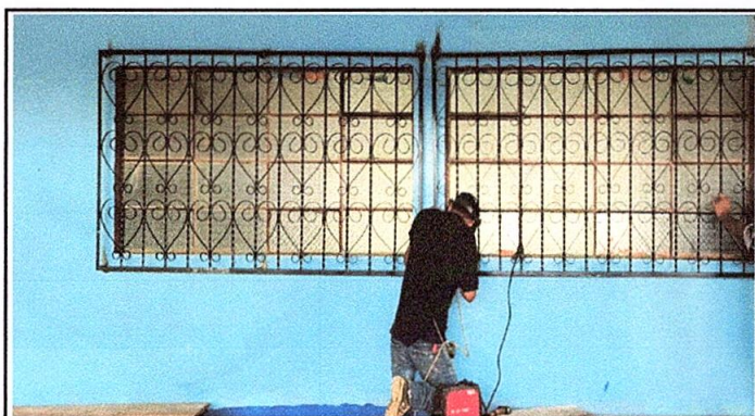
Foto 3: Sustitucion de balcones de metal
