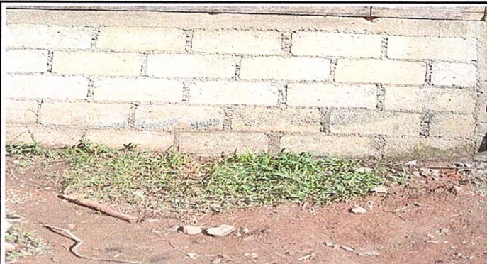
Foto 7: Repello en muro
