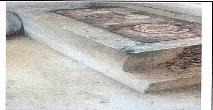
Foto 6: Sustitución de plancha de metal de 3 hornillas
