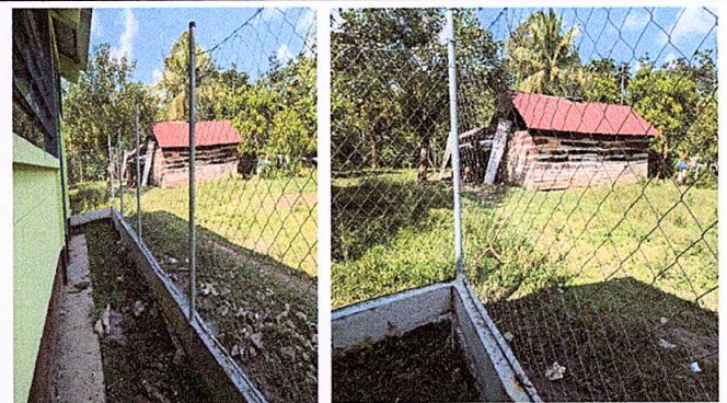
Foto 4: Reparación de tubo hg y malla galvanizada
