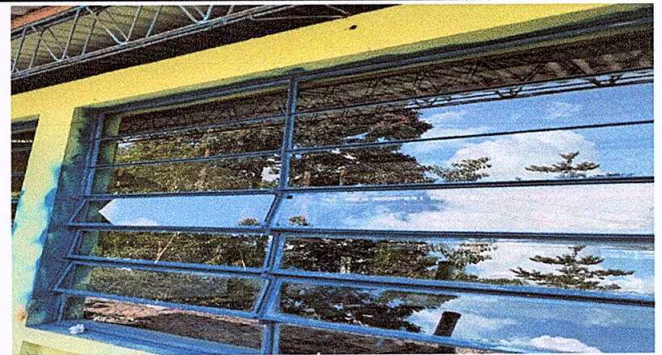
Foto 6: sustitución de vidrios
