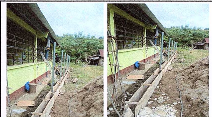
Foto 4: Reparación de tubo hg y malla galvanizada
