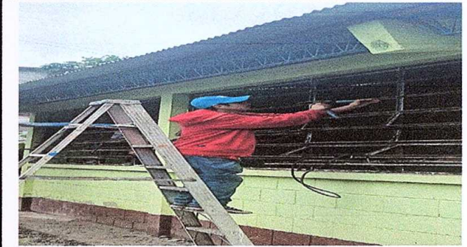
Foto 6: sustitucion de vidrios
