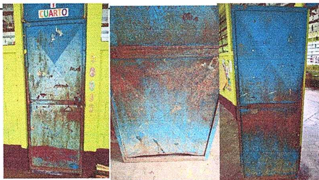
Foto 3: Una puerta para mantenimiento y sustitución de 3 puertas
