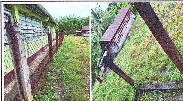
Foto 4: Reparación de tubo hg y malla galvanizada
