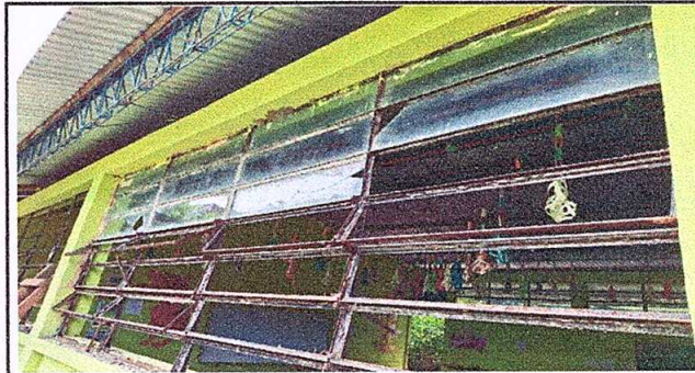
Foto 6: sustitución de vidrios
