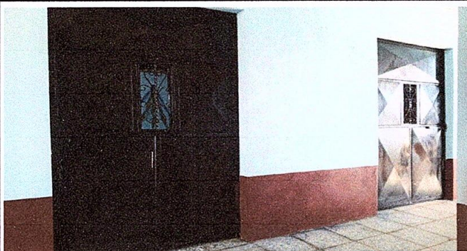
Foto 3: Sustrucción de puerta metal.
