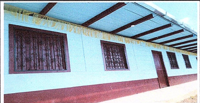
Foto 6: Pintura en muros exteriores e interiores.
