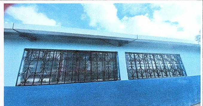
Foto 4: Ventanas y Balcones (1 m de ancho x 2 m de largo)
