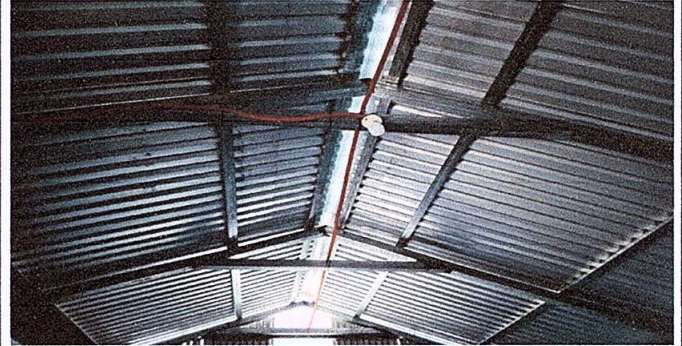
Foto 2: Sustrucción de estructura de soporte de madera, por tubo de metal.
