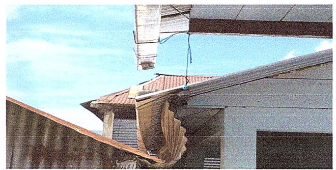
Foto 8: Sustrucción de canal de metal.
