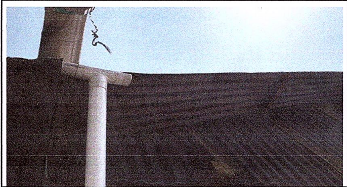
Foto 10: Bajada de Agua Pluvial
