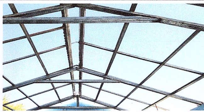
Foto2: Sustrucción de estructura de soporte de madera, por tubo de metal.
