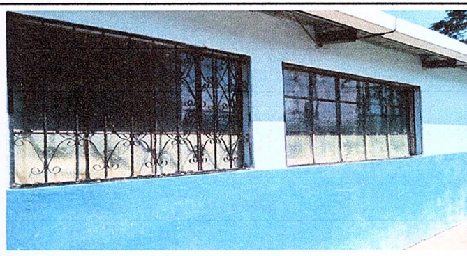
Foto4: Sustrucción de balcones de metal (1 m de ancho x 2 m de largo)
