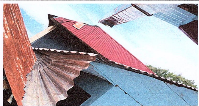
Foto 8: Sustitución de canal de metal.
