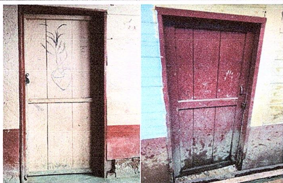
Foto3: Sustrucción de puerta metal.
