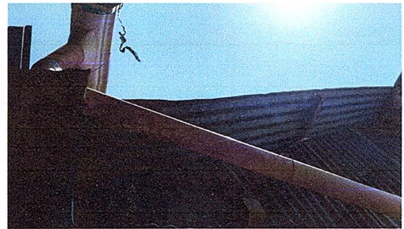
Foto 10. Bajada de Agua Pluvial
