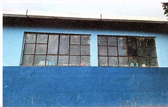
Foto4: Ventanas y Balcones (1 m de ancho x 2 m de largo)
