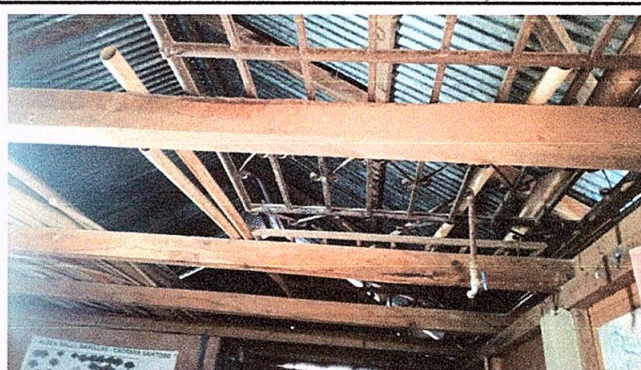
Foto2: Sustrucción de estructura de soporte de madera, por tubo de metal.
