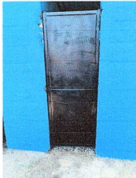
FOTO No. 2: Sustrucción de puerta de servicio sanitario.
