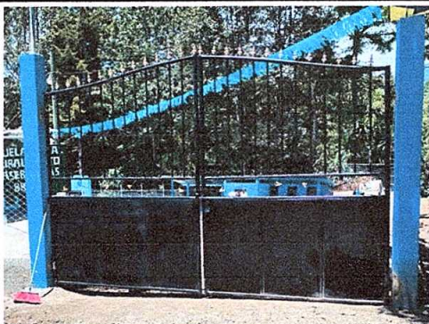
FOTO No. 3: Sustrucción de portón de metal.
