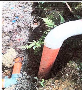
FOTO No. 6: Sustrucción de tubería PVC línea principal aguas negras.
