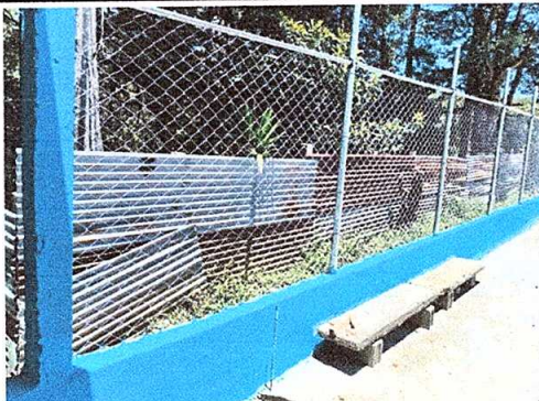
FOTO No. 7: Reparación de tubo hg y malla galvanizada.
