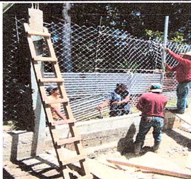
FOTO No. 7: Reparación de tubo hg y malla galvanizada.
