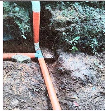
FOTO No. 6: Sustrucción de tubería PVC línea principal aguas negras.
