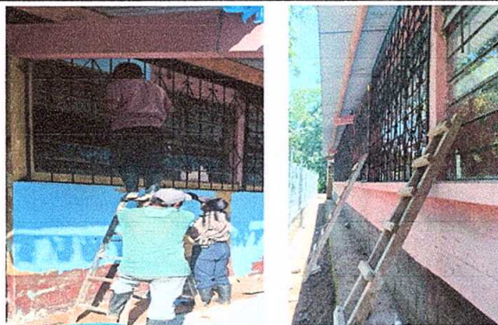
FOTO No. 4: Mejoramiento y mantenimiento de balcones de metal.
