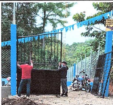
FOTO No. 3: Sustrucción de portón de metal.
