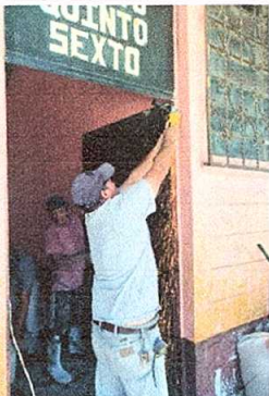
FOTO No. 1: Sustrucción de puerta de madera a metal y de metal a metal.
