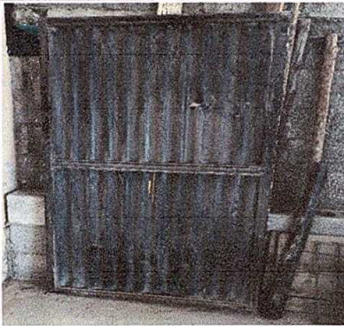
FOTO No. 3: Sustrucción de portón de metal.
