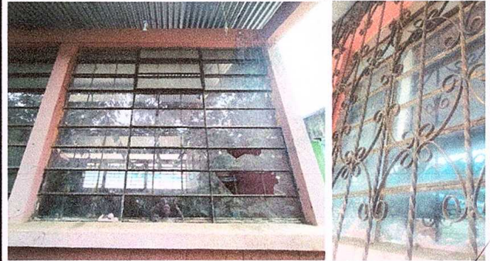
FOTO No. 4: Mejoramiento y mantenimiento de balcones de metal.
