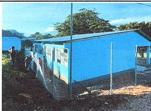
Foto 5: Reparación de tubo hg y malla galvanizada
