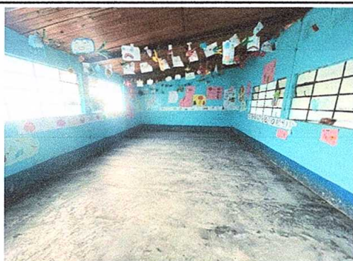
Foto 3: Sustitución de piso de torta de concreto
