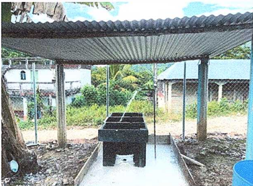
Foto 7: Sustitución de pila de cemento de dos lavaderos
