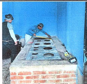
Foto 6: Sustitución de plancha de metal de 3 hornillas
