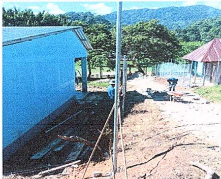
Foto 5: Reparación de tubo hg y malla galvanizada
