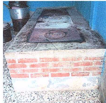
Foto 6: Sustrucción de plancha de metal de 3 hornillas
