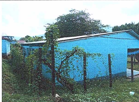
Foto 5: Reparación de tubo hg y malla galvanizada
