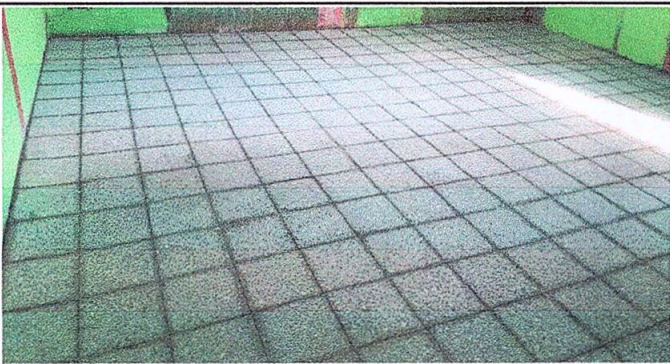
Foto 3: Reparacion de piso en malas condiciones
