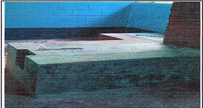
Foto 4: sustitucion de plancha de metal de tres hornillas
