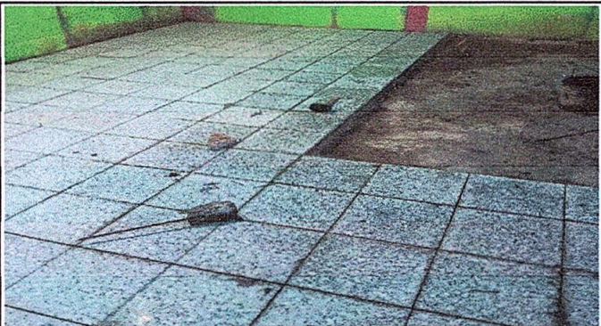
Foto 3: Reparacion de piso en malas condiciones
