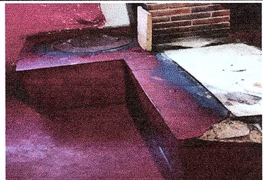
Foto 4: sustitucion de plancha de metal de tres hornillas
