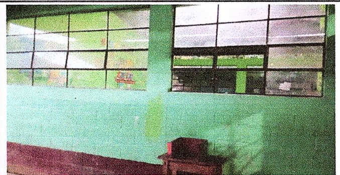
Foto 6: reparacion de ventanas
