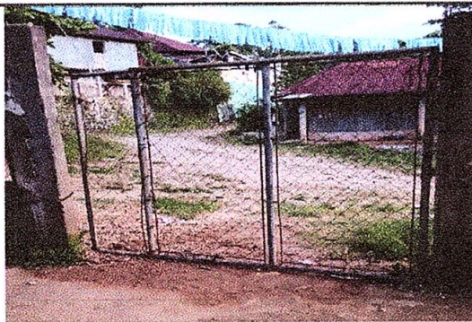
Foto 5: Sustitucion de porton de metal
