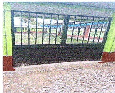
Foto 8: Sustrucción de portón de metal
