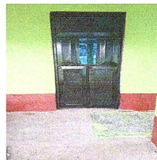
Foto 4: Mantenimiento a estructura de puerta de metal
