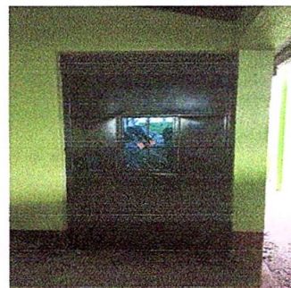
Foto 6: sustitución de puerta 100 x 200
