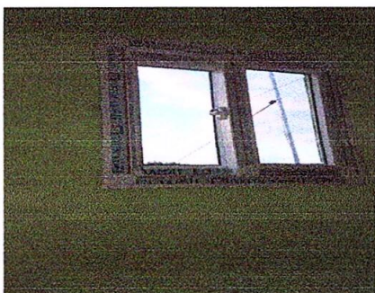
Foto 9: Sustrucción de ventanas de madera por metal
