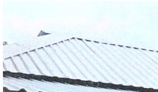
Foto 2: sustitución de capotes de lámina para lámina troquelada
