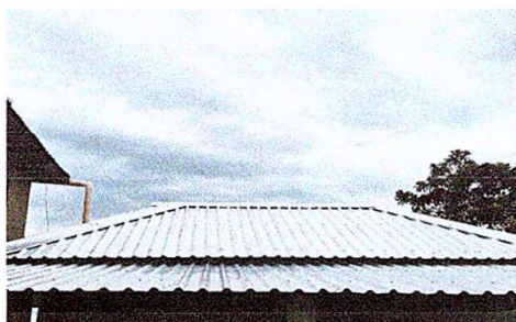
Foto1: Sustitución de lámina
