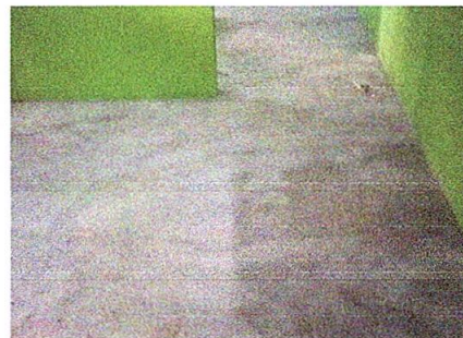
Foto 10: Sustrucción de piso de torta de concreto
