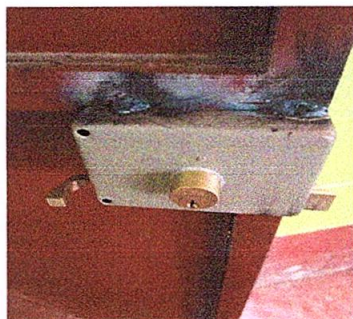
Foto 5: Sustitución de chapa
