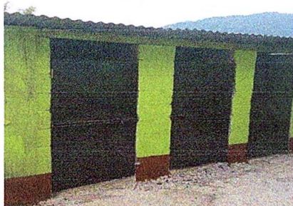
Foto 7: Sustrucción de puerta en servicios sanitarios
