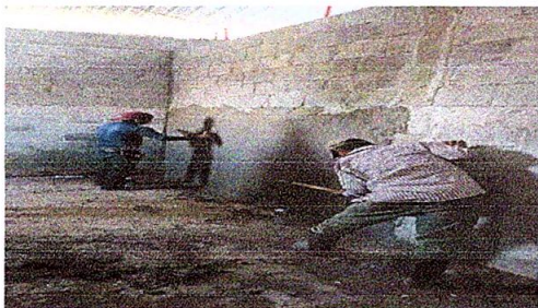
Foto13: Repello en muros
