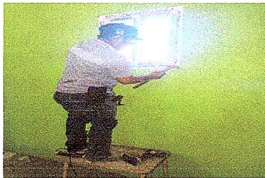
Foto 9: Sustitución de ventanas de madera por metal
