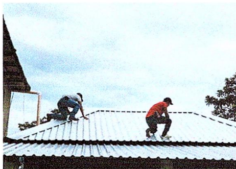
Foto1: Sustitución de lámina
