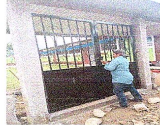
Foto 8: Sustitución de portón de metal
