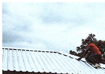
Foto 2: sustitución de capotes de lámina para lámina troquelada
