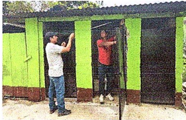
Foto 7: Sustitución de puerta en servicios sanitarios
