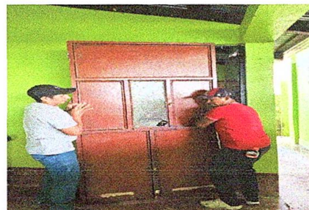
Foto 6: sustitución de puerta 100 x 200
