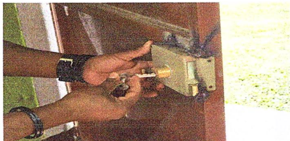
Foto 5: Sustitución de chapa
