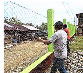
Foto 12: Reparación de malla galvanizada
