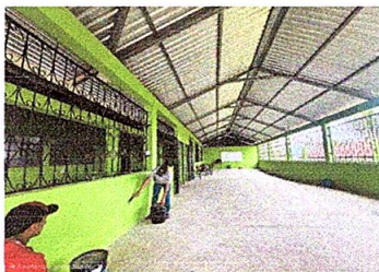
Foto 11: Pintura en muros exteriores e interiores
