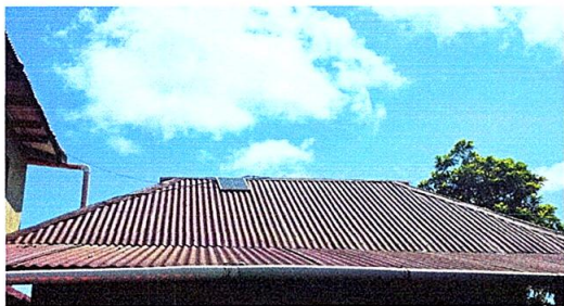
Foto 1: Sustrución de lámina
