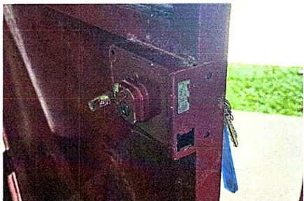
Foto 5: Sustrución de chapa
