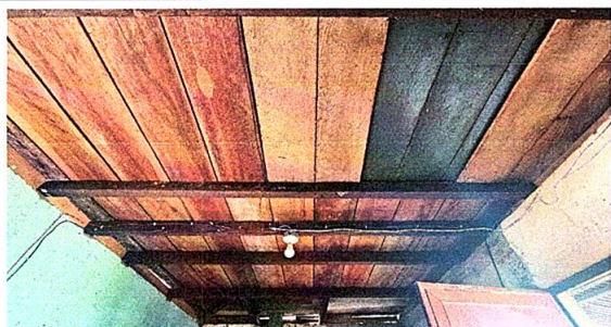
Foto 3: Sustrución de estructura de soporte de madera por metal
