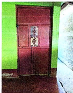
Foto 6: sustrución de puerta 100 x 200
