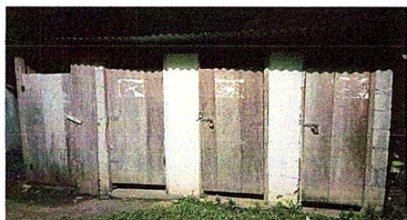
Foto 7: Sustrucción de puerta en servicios sanitarios
