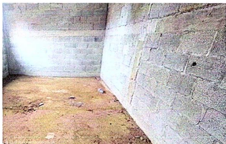
Foto13: Repello en muros
