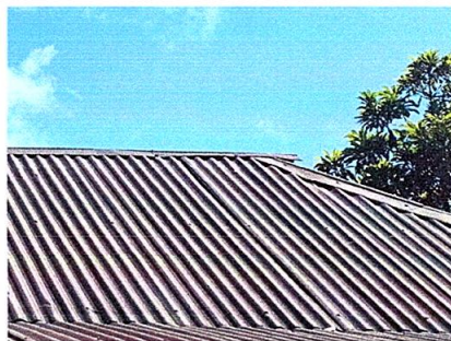
Foto 2: sustrución de capotes de lámina para lámina troquelada
