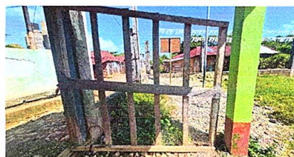
Foto 8: Sustrucción de portón de metal
