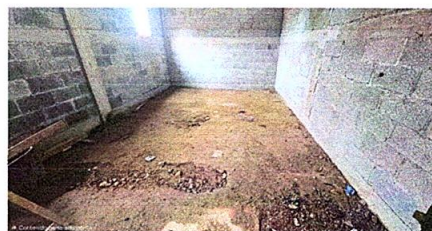
Foto 10: Sustrucción de piso de torta de concreto
