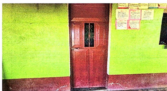
Foto 4: Mantenimiento a estructura de puerta de metal
