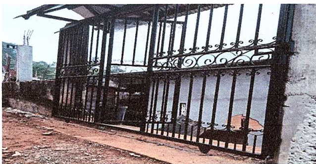
Foto 5: Sustitución de portón de metal (3.49m * 2.30m)
