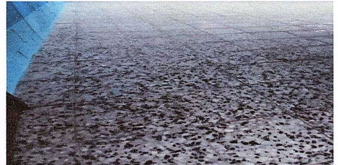
Foto 4: Sustitución de piso por piso de granito
