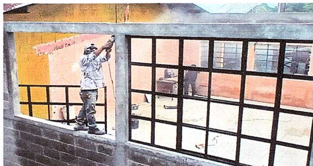
Foto 1: Sustitución de estructura de metal de ventana (2.30m * 1.80m)
