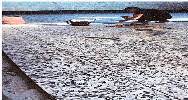
Foto 4: Sustitución de piso por piso de granito
