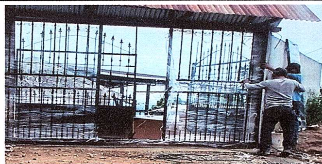
Foto 5: Sustitución de portón de metal (3.49m * 2.30m)
