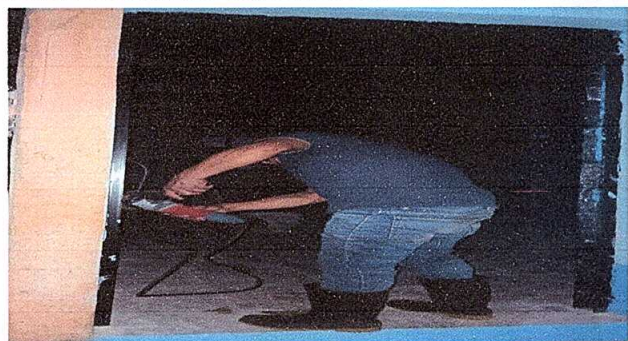
Foto 3: Sustitución de puerta (2.10m * 1.00m)
