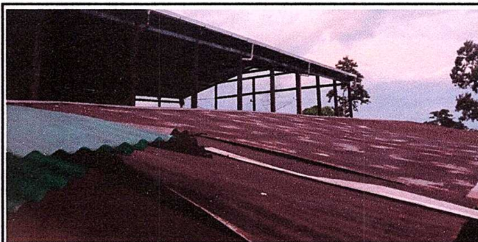
Foto 6: Sustitución de lámina por lámina troquelada aluzinc calibre 26
