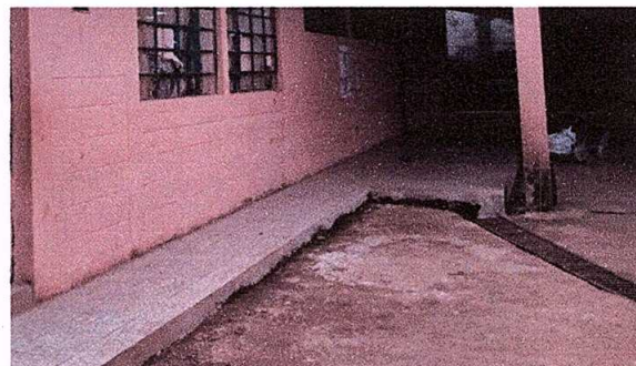
Foto 4: sustitución de piso por piso de granito
