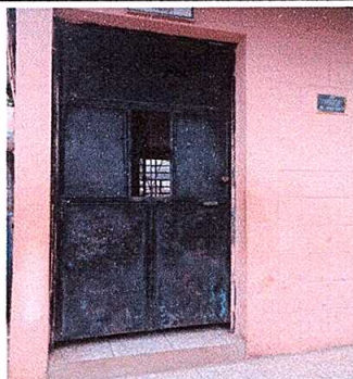
Foto 3: sustitución de puerta (2.10m x 1.00m)
