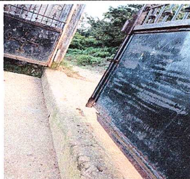
Foto 5: sustitución de portón de metal (3.49 m x 2.30m)
