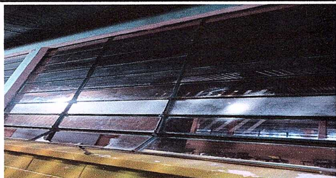
Foto 1: sustitución de estructura de metal de ventana (2.30m x 1.80m)
