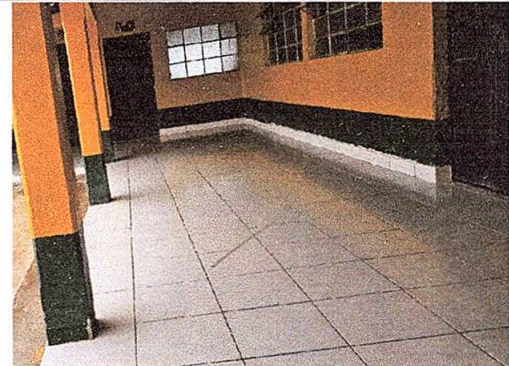
Foto 2: LOSA DE PATIO
