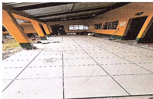
Foto 2: LOSA DE PATIO
