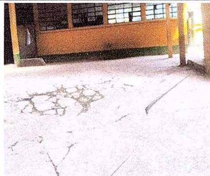
Foto 2: LOSA DE PATIO
